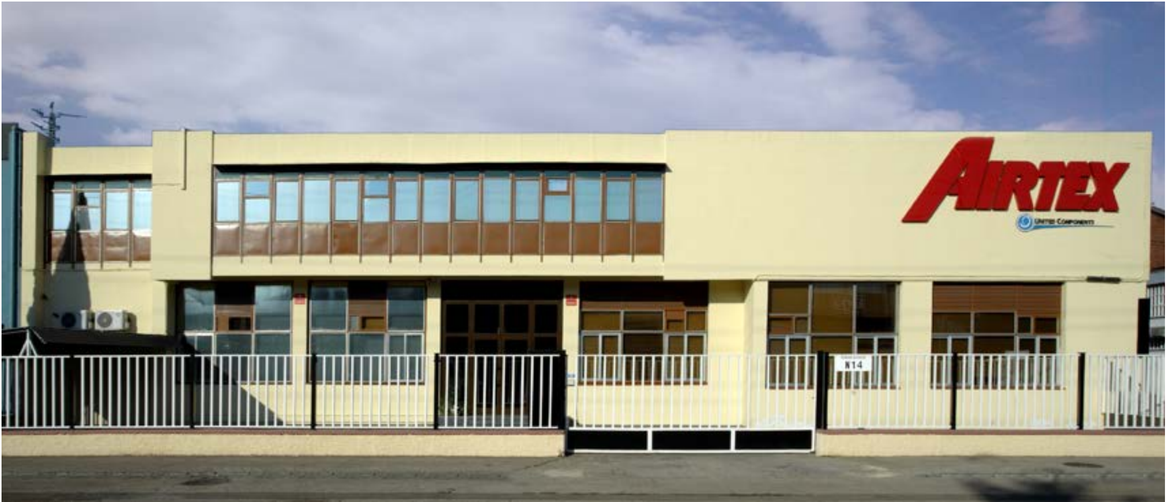
Instalaciones de AIRTEX en Cogullada
